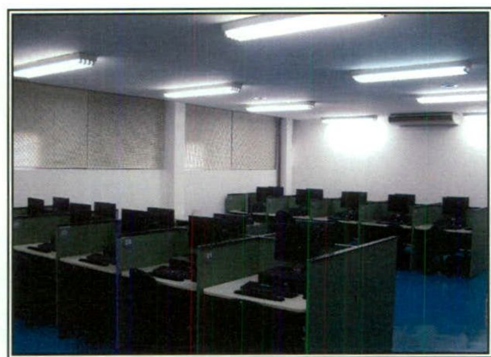
Central de Processamento de Dados
